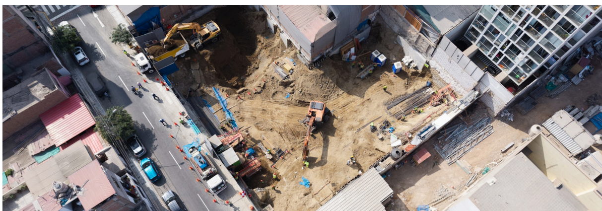
AVANCE DE OBRA - BARRANCO
